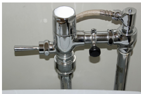
自動流水器設置前
