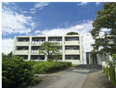
緑あふれる 東京・スチューデント ハウスつつじヶ丘の外観
