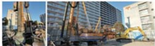
計画地の工事風景 (2011年12月撮影)
